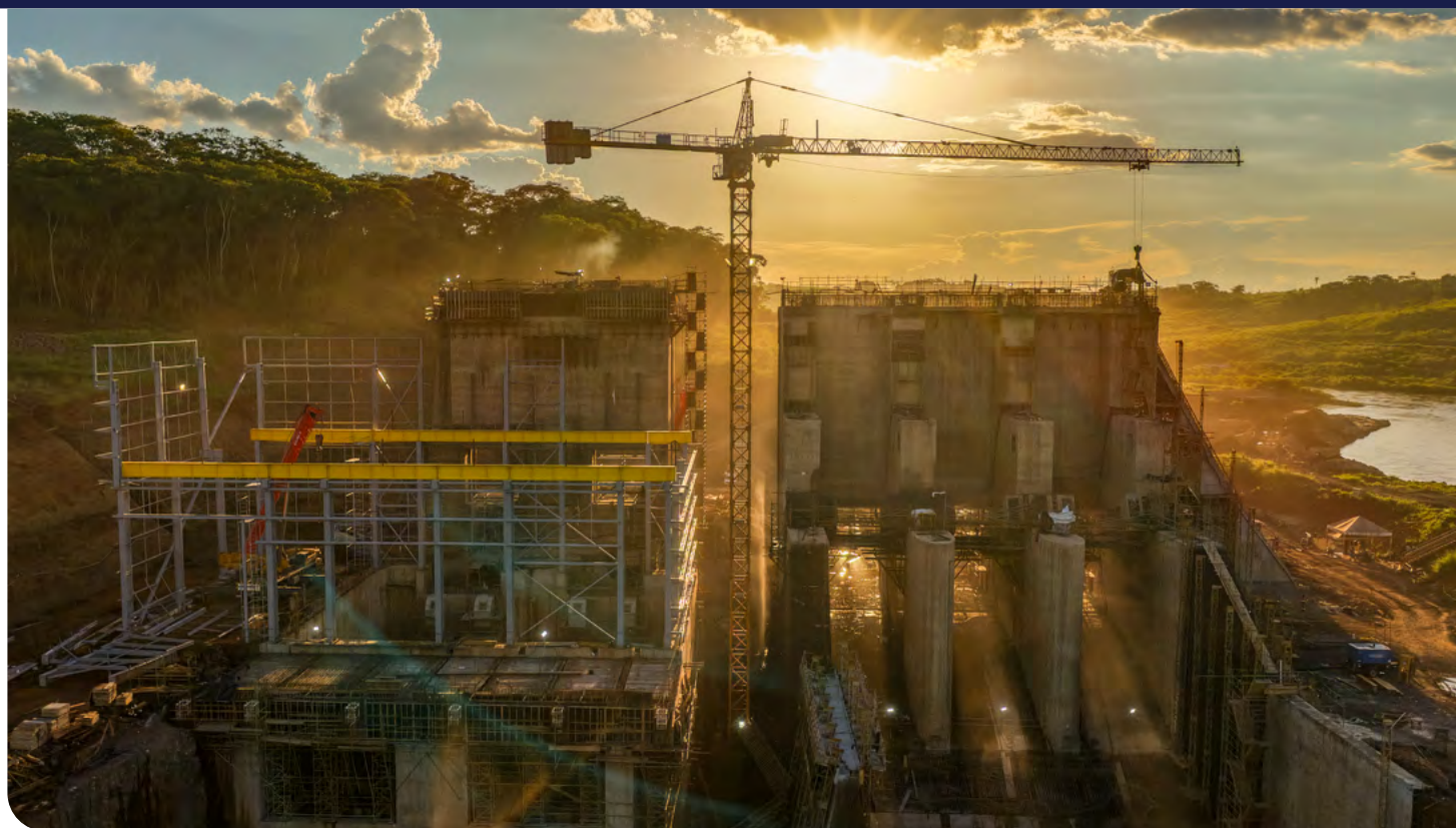
Obra UHE Estrela – Foto: Christopher Borges (colaborador)
