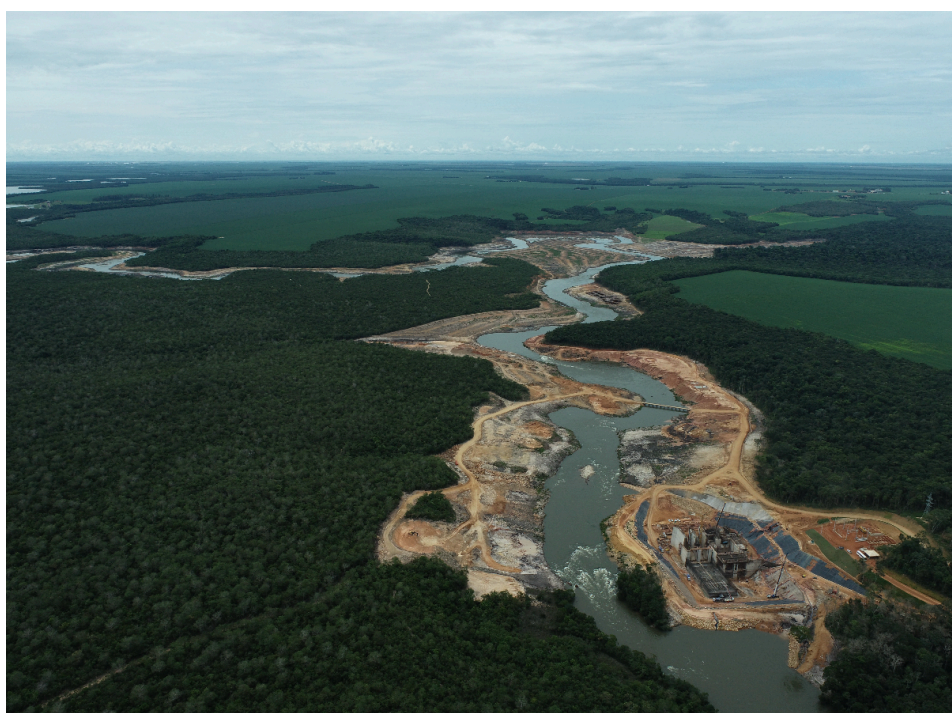
Figura 2 – Vista da PCH e do vale, em dezembro de 2021
