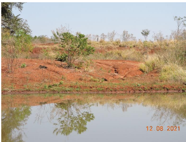
Figura 6. Erosão laminar no ponto 3, localizado na margem do reservatório. Programa de Prevenção e Controle de Erosão e Assoreamento do Reservatório da PCH Bandeirante, Água Clara, MS. Agosto de 2021.
