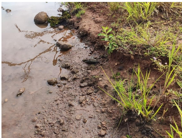
Figura 13.3.1-2: Erosão laminar no ponto 1, localizado na margem do reservatório. Programa de Prevenção e Controle de Erosão e Assoreamento do Reservatório da PCH Bandeirante, Água Clara, MS. Fevereiro de 2022.
